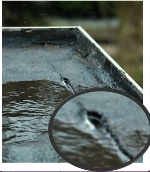
Defekte Dachabdichtungen
