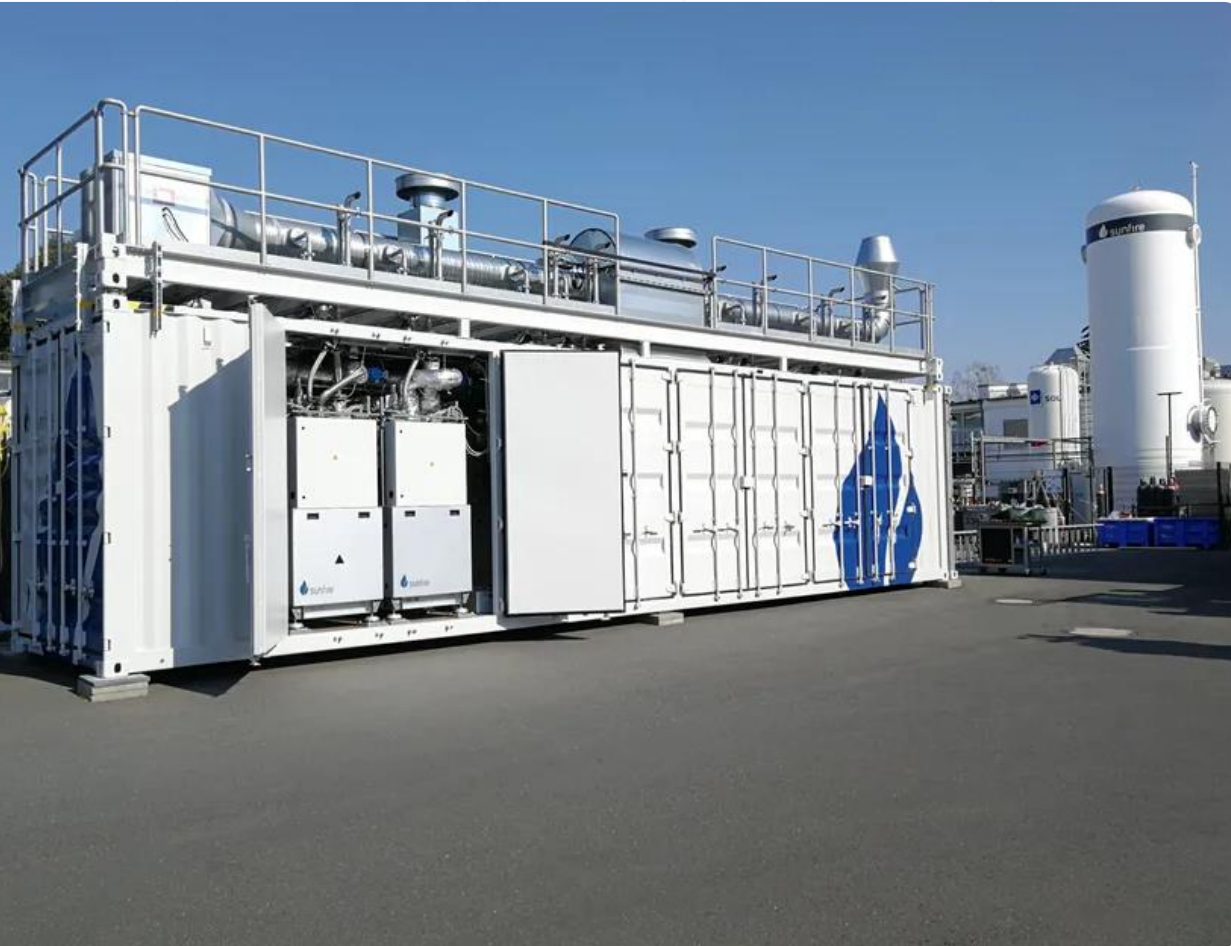
Sunfire SOEC-Elektrolyseur im Stahlwerk Salzgitter, Chemie.de
